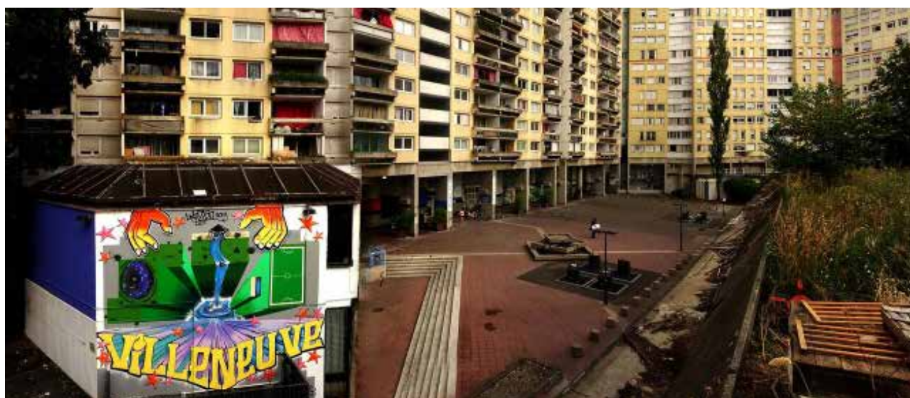
61, Galerie de l'Arlequin, Villeneuve, Grenoble
